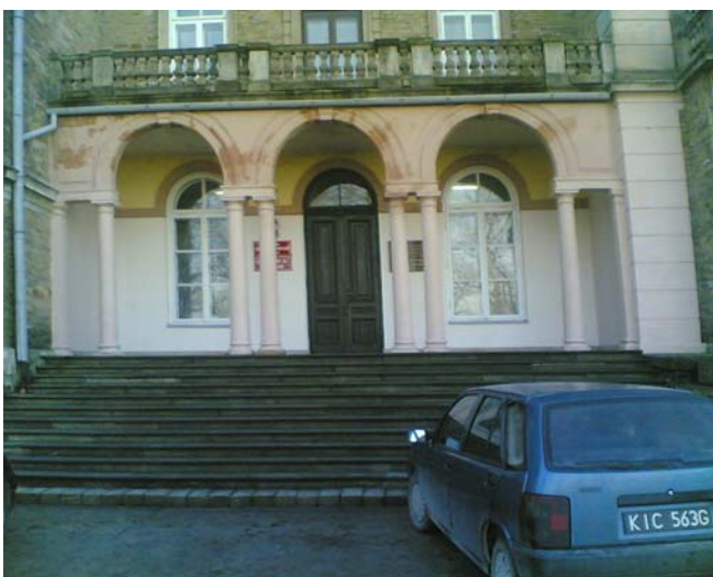
Budynek pałacu: elewacja północna (główne wejście do pałacu) Fot. Agnieszka Skrzypczak
