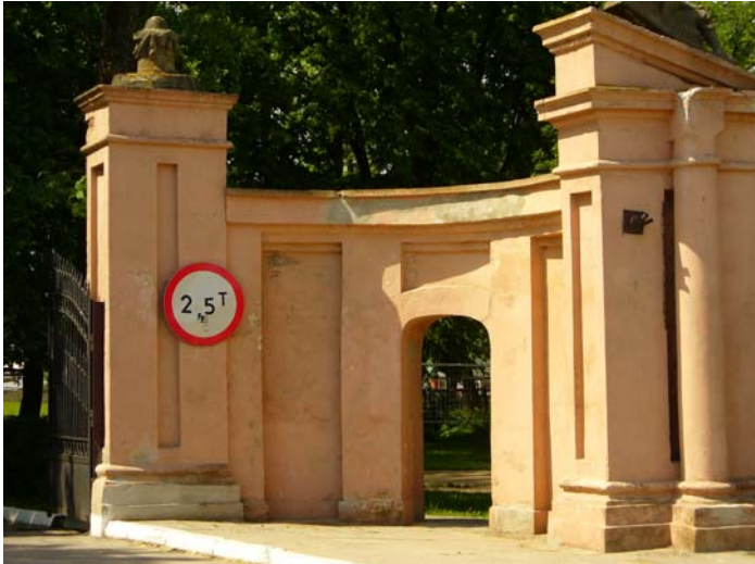
Brama wjazdowa: prawe skrzydło: widok od strony ul. Koneckiej Fot. Agnieszka Skrzypczak
