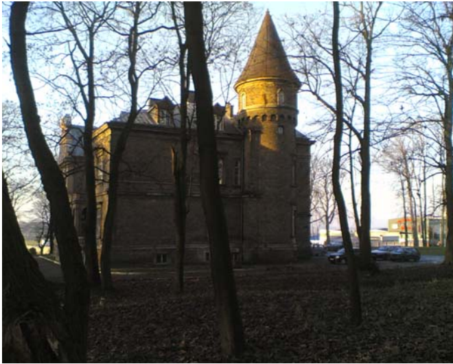
Budynek pałacu: elewacja wschodnia (widok od strony ul. Koneckiej) Fot. Agnieszka Skrzypczak
